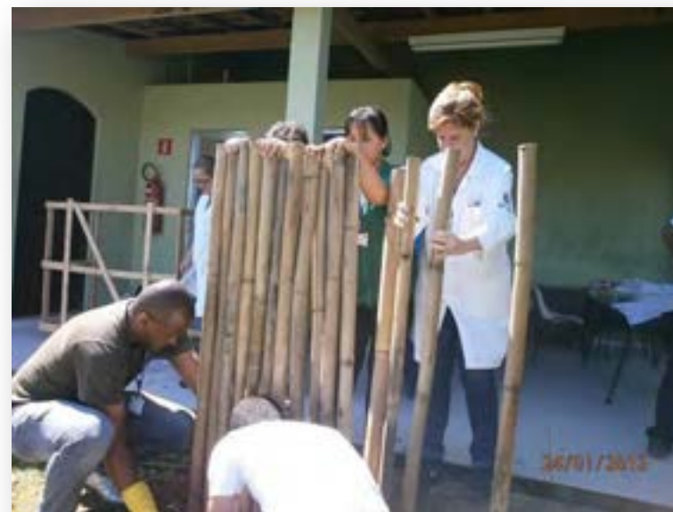
Construção de cerca de bambus na área de convivência dos funcionários da UBS
